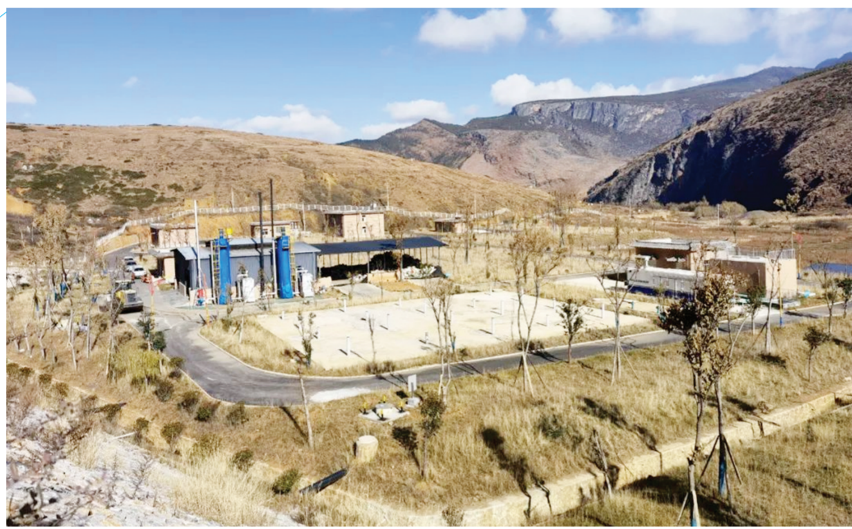
近日,农发行云南宁蒗县支行向宁蒗彝族自治县开发投资有限公司发放6000万元农村土地流转和土地规模经营贷款,用于支持宁蒗县提升农村人居环境“一水两污”项目建设。该项目主要建设内容为新建9个供水项目、9个污水处理项目、10个垃圾处理设施及乡镇公厕和户厕设施改造。在了解到项目资金需求后,该行切实提高政治站位,坚持以党建统领业务发展,以“融智、融资、融力”为着力点,迅速成立办贷攻坚小组,及时发放贷款,为巩固脱贫攻坚成果同乡村振兴有效衔接注入金融“活水”。图为该行支持的“一水两污”项目。 蒋家豪
