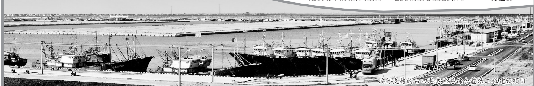
该行支持的吕四港老渔港综合整治工程建设项目
