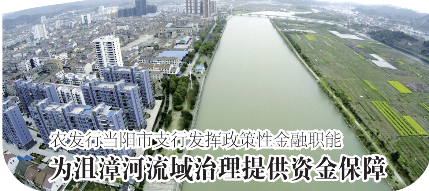
▼ 图为当阳市沮漳河及其支流综合治理工程河道护岸
