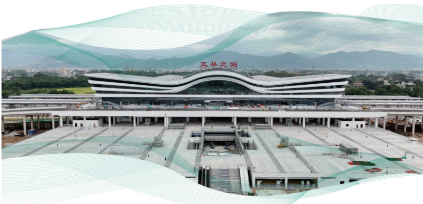
农发行玉林分行支持的玉林北站高铁综合交通枢纽中心综合体建设项目
